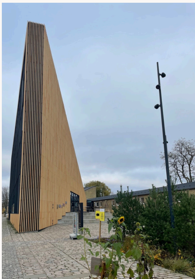
Tingbjerg Bibliotek \ Kulturhus (til venstre) er bygget i direkte forlængelse af Tingbjerg Skole (til højre).
